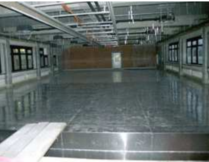
Die großflächige Abschirmung eines Bürogebäudes gegen eine darunterliegende Trafostation mit Aaronia MagnoShield® Abschirmplatten
