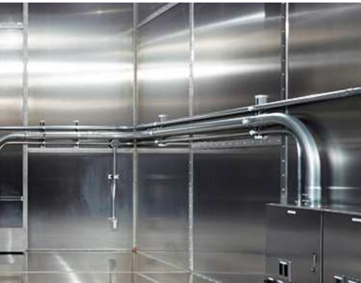
Die großflächige Abschirmung eines Traforaumes gegen angrenzende Büroräume mit Aaronia MagnoShield® DUR Abschirmplatten
