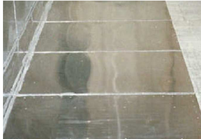
Auch großflächige Magnetfeldabschirmungen sind mit Aaronia MagnoShield® Abschirmplatten problemlos zu erstellen
